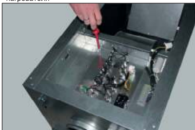
4. Зафиксируйте нагреватель с помощью саморезов
