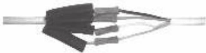
1. Кабель разделяют в соответствии с необходимой длиной оголенного проводника для соединения. На кабель и его жилы одевают маленькие внутренние трубы, а также внешнюю трубку большего диаметра. Подсоединение жил производят опрессовкой соединителей.
