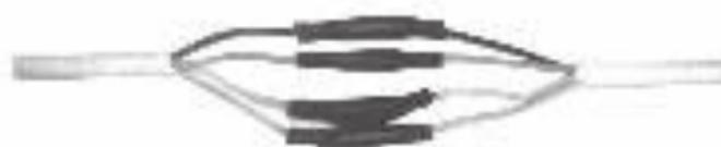
2. Внутренняя трубка поочередно размещается над соединителями и нагревается струей горячего воздуха при помощи строительного электрофена до полной усадки. Внутренний слой клея при нагревании плавится и растекается, такое склеивание обеспечивает герметизацию и защиту от коррозии , а кабелю дает возможность расширяться и сжиматься при тепловых воздействиях на него.
