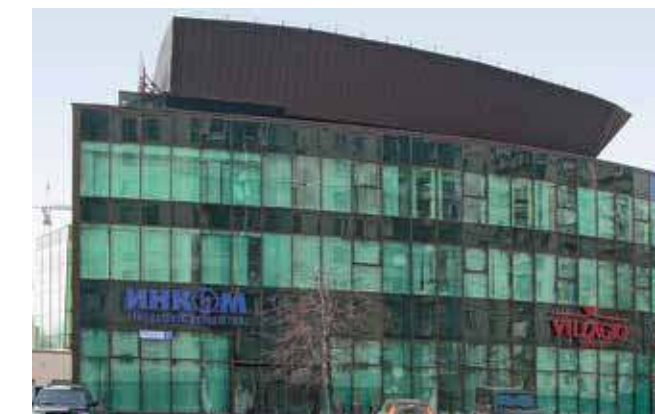
Офисный центр компании «ИНКОМ», г. Москва
