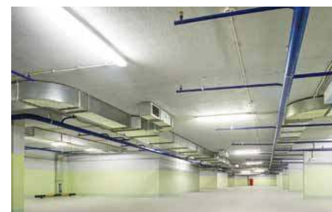
Подземная двухуровневая автостоянка, г. Королев
