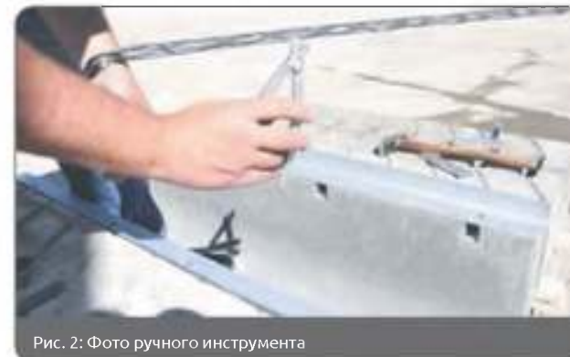
Рис. 3: Фото сжатие упорных полок при распорных клещей
