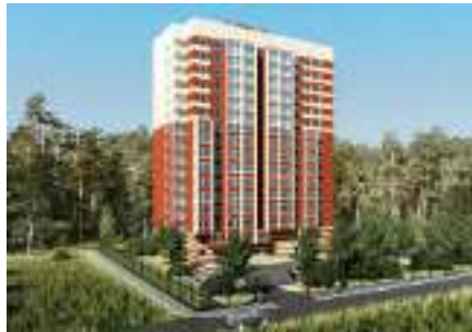
ЖК Прилесный (г.Пермь) 2017г.
