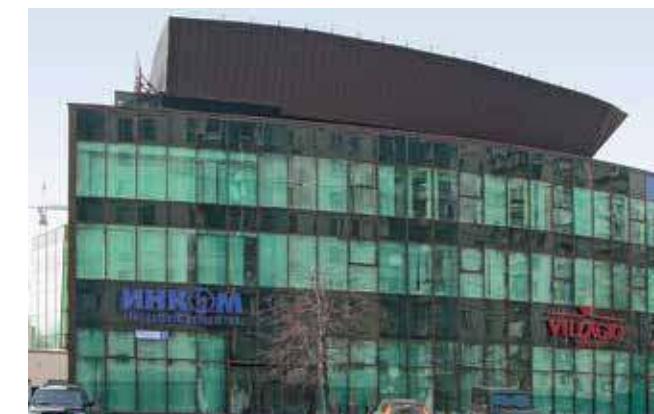
Офисный центр компании «ИНКОМ», г. Москва
