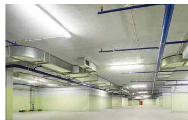
Подземная двухуровневая автостоянка, г. Королев
