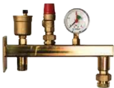
Рис. 15. Группа безопасности для расширительных баков
