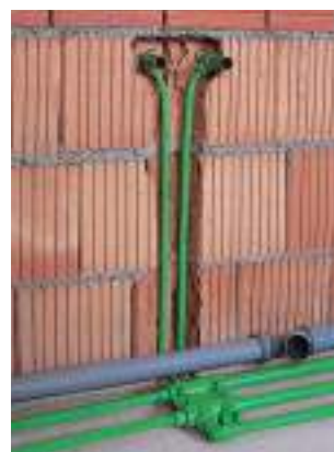
Монтаж под штукатурку
