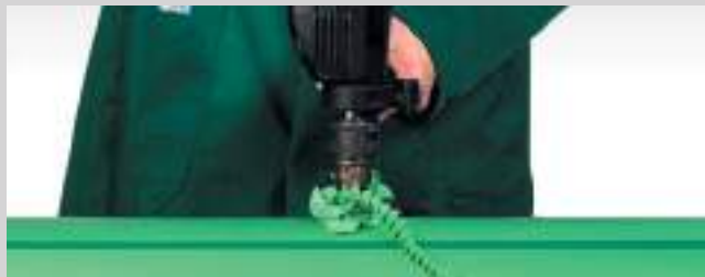
Сверление отверстия в стенке трубы
