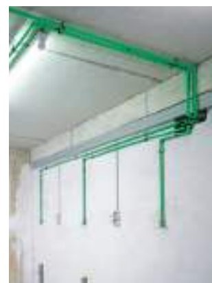
Монтаж на штукатурку
