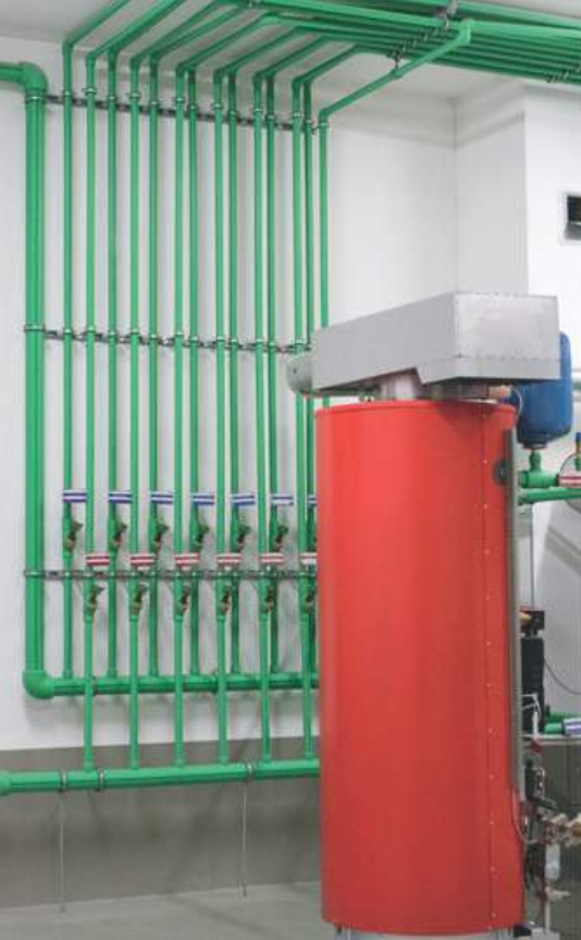
Распределитель для систем водоснабжения и отопления в жилом здании
