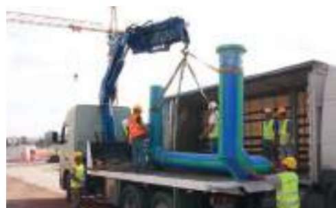
Доставка на стройплощадку
