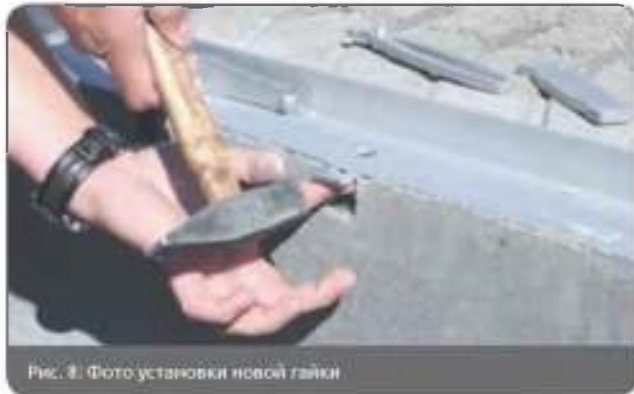
Рис. 9: Фото усадки сменной гайки
