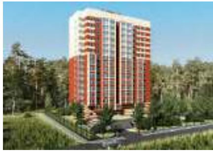
ЖК Прилесный (г.Пермь) 2017г.
