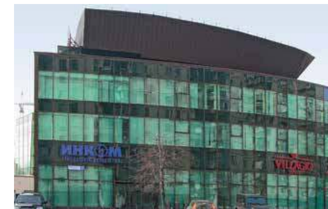
Офисный центр компании «ИНКОМ», г. Москва
