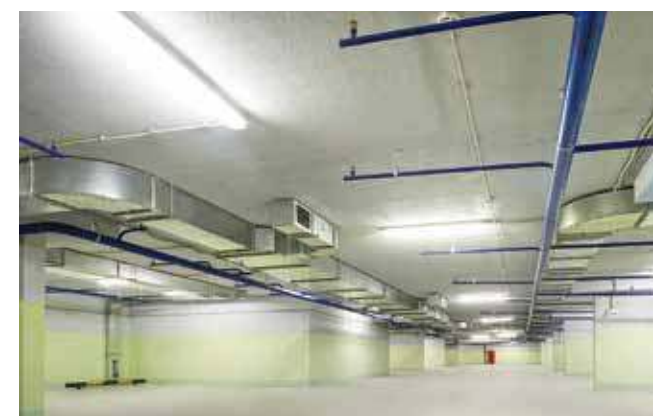
Подземная двухуровневая автостоянка, г. Королев
