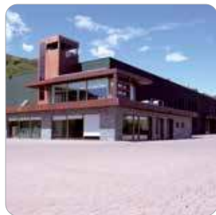
NEW PRODUCTION UNIT San Maurizio d'Opaglio (NO)
