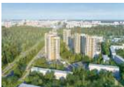
ЖК Покровский (г.Ижевск) 2019г.
