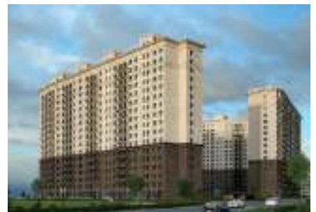
ЖК Котельнические высотки (МО, г.Котельники) 2017г.
