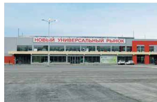
Муниципальный рынок, г. Рязань
