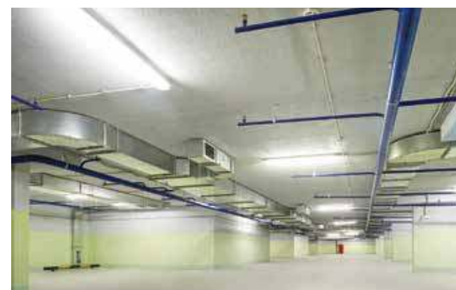
Подземная двухуровневая автостоянка, г. Королев
