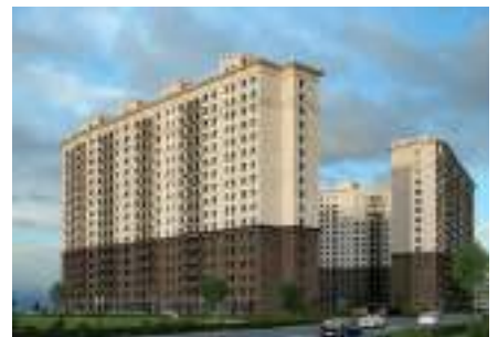
ЖК Котельнические высотки (МО, г.Котельники) 2017г.
