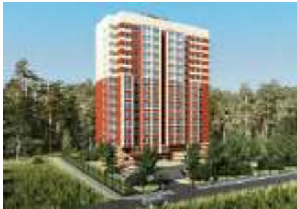
ЖК Прилесный (г.Пермь) 2017г.
