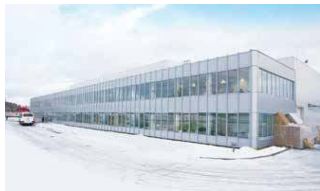
Производственно-складской комплекс «ДЕЛЕР НФ И БИ», г. Лобня
