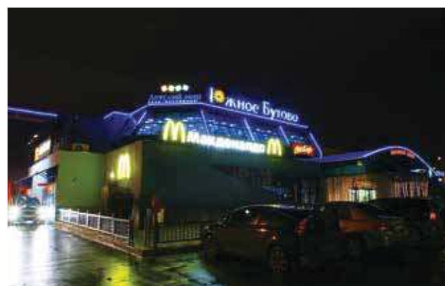
Торговый центр «Южное Бутово», г. Москва
