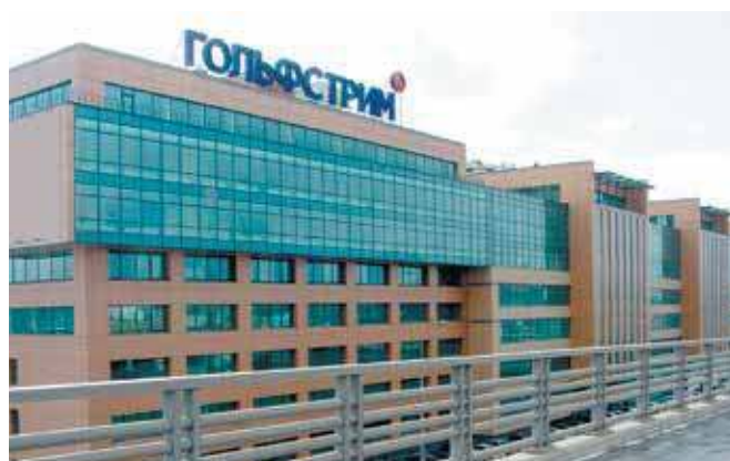
Офисный центр «Гольфстрим», г. Москва
