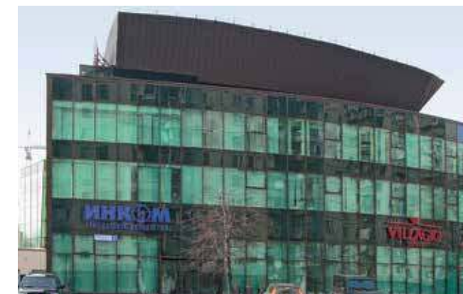
Офисный центр компании «ИНКОМ», г. Москва
